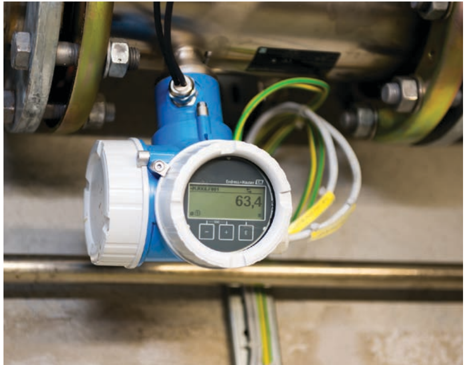
Proline Prosonic Flow B 200 er en ultralyd mengdemåler som måler mengden på biogassen fra råtnetanken med stor nøyaktighet. Innhold av metangass måles direkte. Her viser måleren at metaninnholdet i biogassen er 63,4%.
