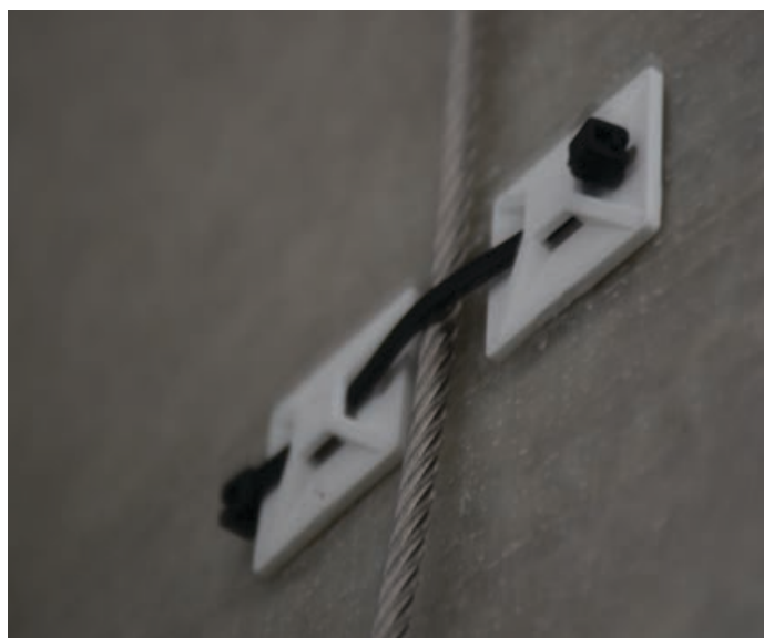
Detaljebilde av hvordan vieren ble festet
