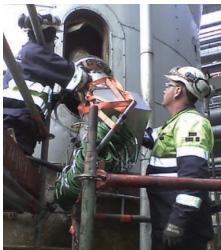
Octoplus Multipointen installeres via en eksisterende flenstilkobling
