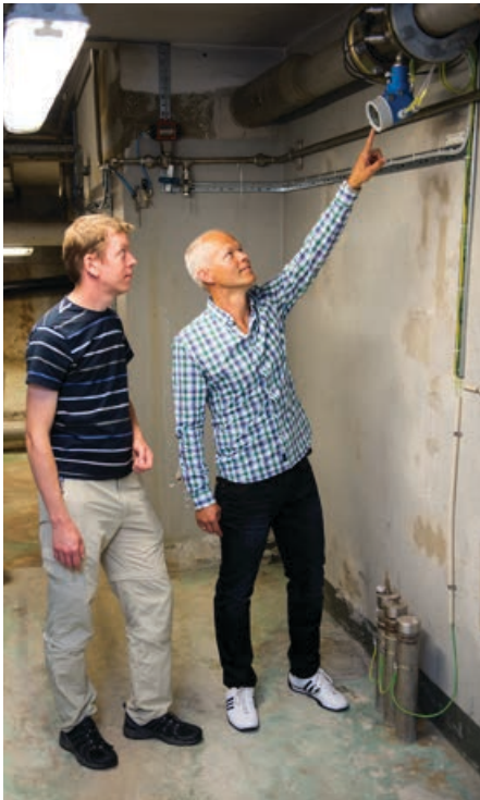
Proline Prosonic Flow B 200 er en ultralyd mengdemåler som måler mengden på biogassen fra råtnetanken med stor nøyaktighet. Innhold av metangass måles direkte. Her viser måleren at metaninnholdet i biogassen er 63,4%.
