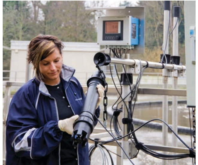
Det ionselektive målesystemet ISEmax CAS40D gir en rask og enkel kontroll av prosesser i avløpsrensingen
