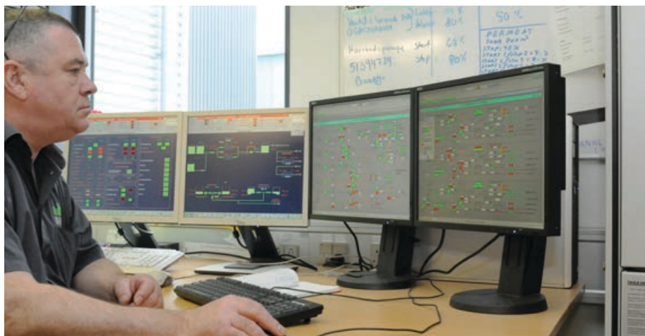
«Måleutstyret fra Endress+Hauser gjør det mulig å drive en effektiv, sikker, miljøvennlig og energioptimalisert avsaltingsanlegg som er fullt integrert med Amagerværkets overordnet styresystem Siemens T3000», sier driftsmedarbeider John Martinussen.
