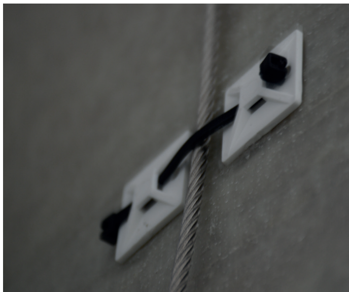
Detaljebilde av hvordan vaieren ble festet
