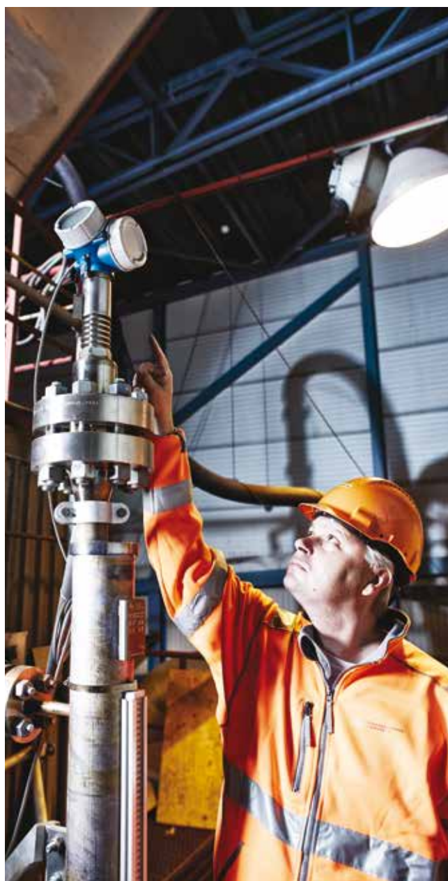
Etter å ha lett i markedet besluttet vi oss for å investere i Endress+Hauser's bypass-system med innebygget guidet radar Levelflex FMP54 og nivåindikering.
