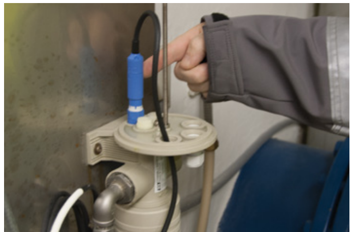
Det er relativt lett å skifte pH-elektroden. Denne slites over tid, fordi referansematerialet i føleren nedbrytes.
