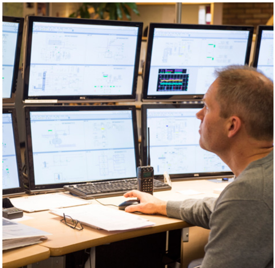
Krister Ehn og hans kolleger fører tilsyn med driften av kjelene og har nå full kontroll på nivået av flis i siloen.
