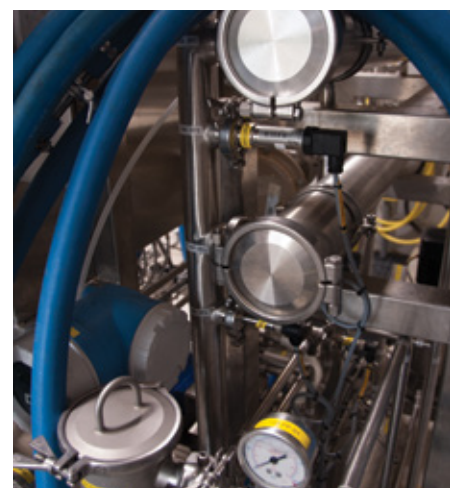
De to filtrerne i forsøksanlegget kan bruke forskjellige membraner, så de forskjellige filtreringsmetoder kan testes ut.
